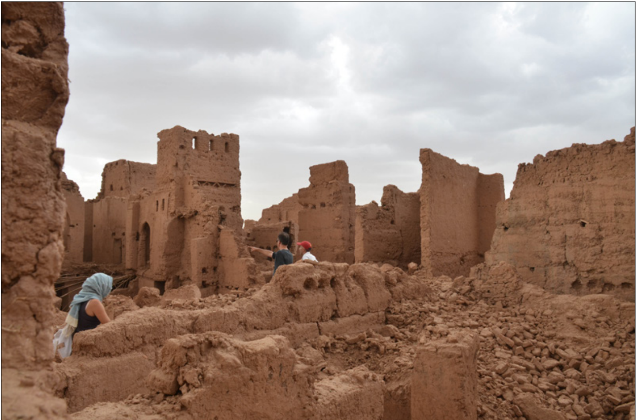
Fig. 3-11 – Le ksar Aghlal Bachar, ou Aghlal Moulay Ismâ‘il (à 200 km de Rissani) illustre la variété des matériaux employés en sus du pisé (adobe, stuc, pierre, brique cuite), la présence d’étages soutenus par des troncs de palmiers, l’action des processus érosifs sur les différents éléments du bâti, les modalités du démantèlement différentiel des vestiges et la réduction progressive, au cours du temps, du module des déblais, formant après plusieurs siècles un tell de limon. Photo : Mission archéologique maroco-française, 2012.
