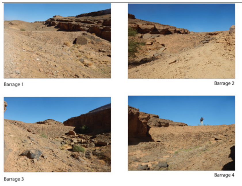
Fig. 10-11 – Parement aval des barrages de la Gara Medouara. Photos Mission archéologique maroco-française, 2016.
