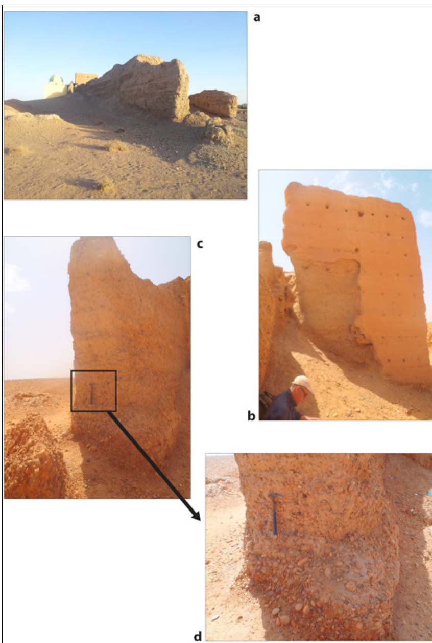
Fig. 4-10 – Vues de la muraille du XIV e siècle : mausolée associé à la muraille (a) ; tour adossée à la courtine principale (b) ; troncature de la muraille (c) avec un détail du matériau (d). Photos : Mission archéologique maroco-française, 2013.
