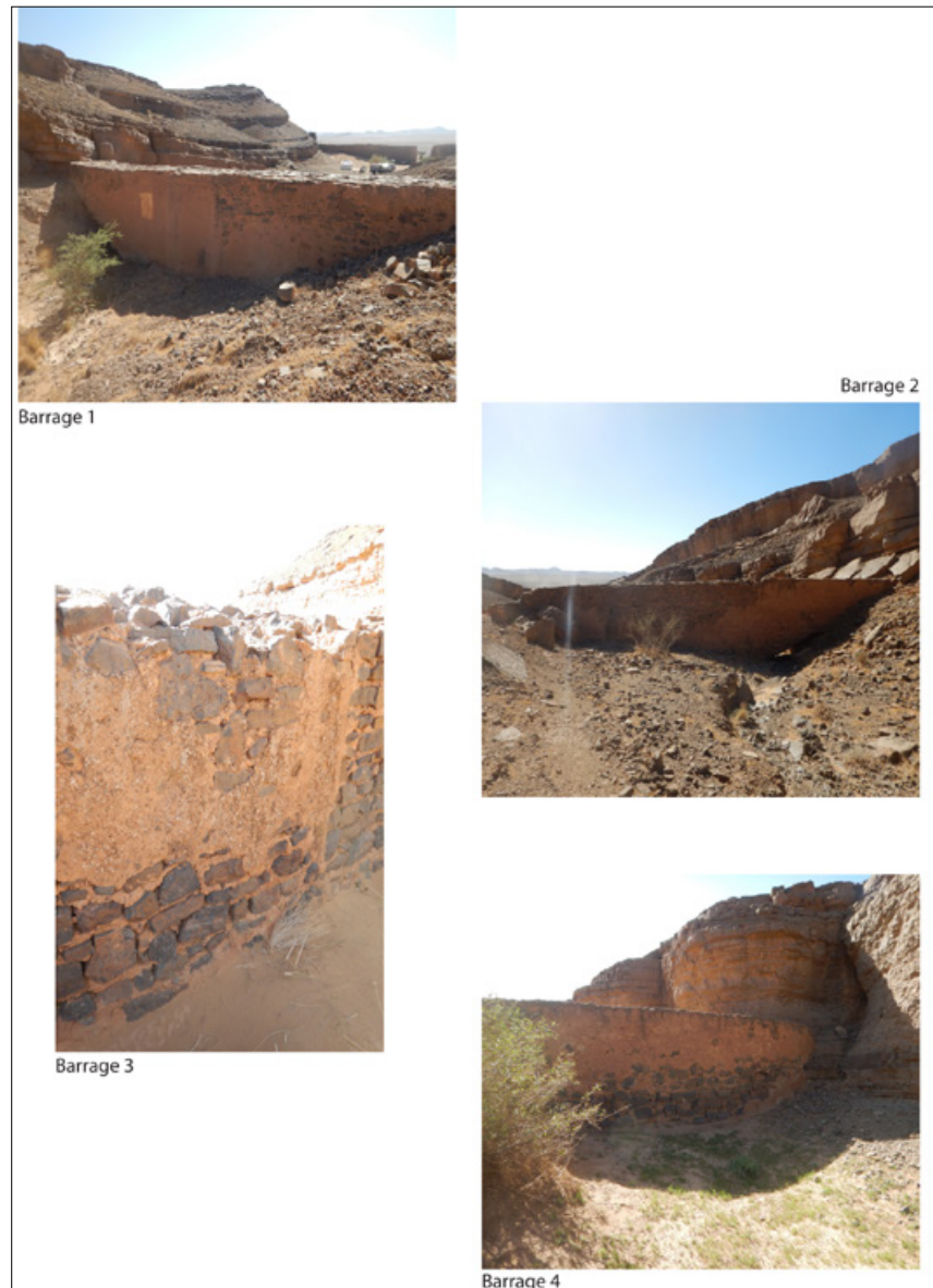
Fig. 10-13 – Parement amont des barrages et détails sur l'enduit de chaux. Photos : Mission archéologique maroco-française, 2016.
